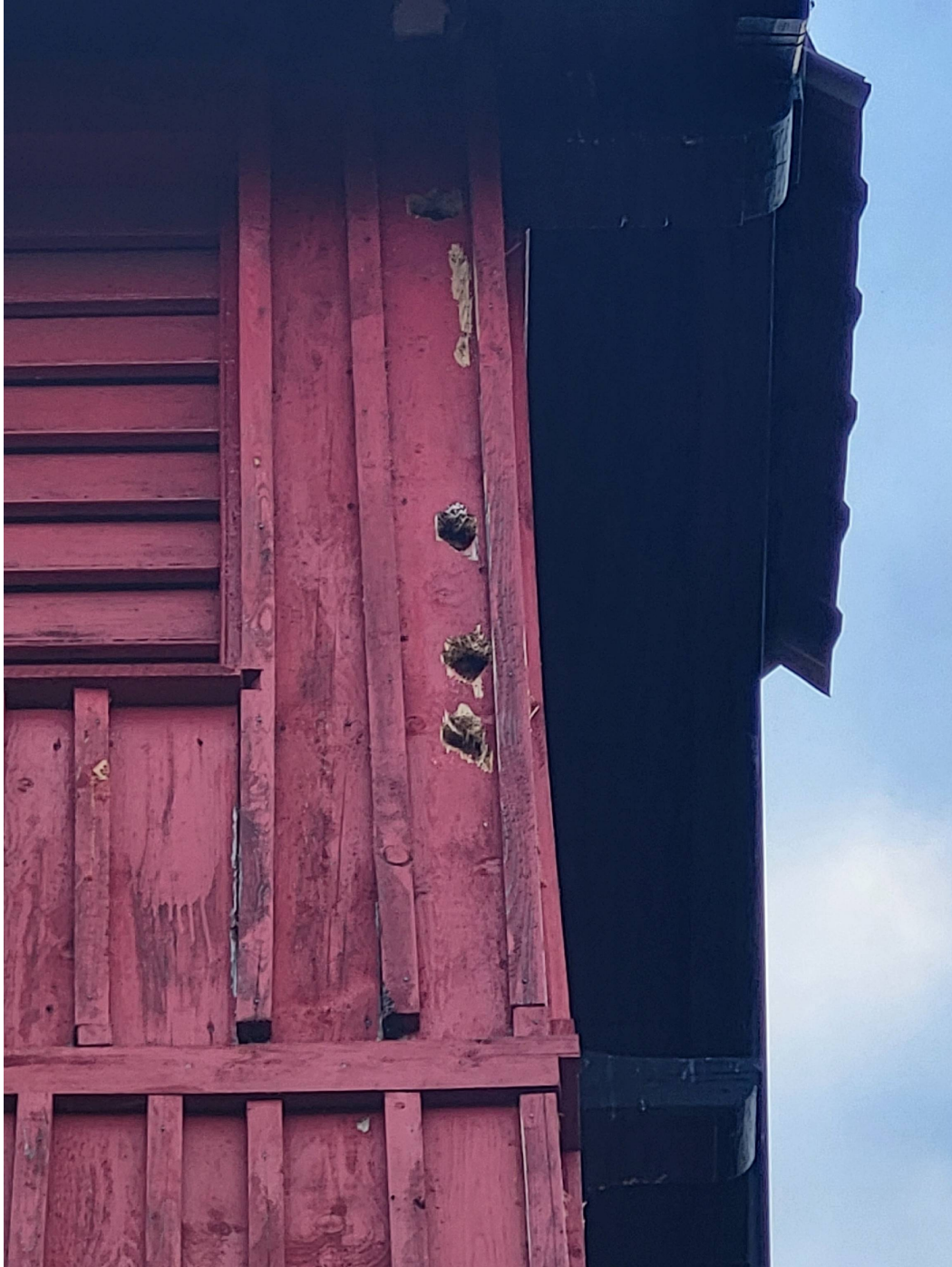
Uszkodzenie drewnianego obicia wieży – fot. 6
