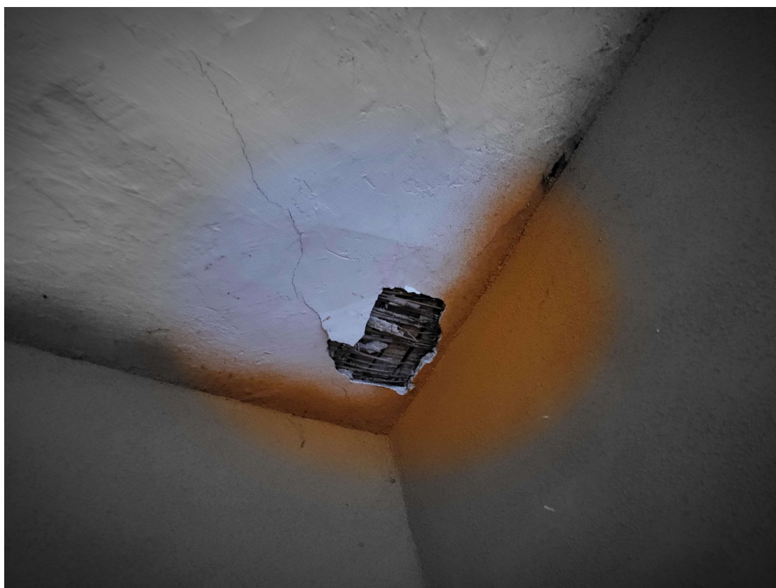
uszkodzenie tynku sufitowego w pomieszczeniu garażowym – fot. 3
